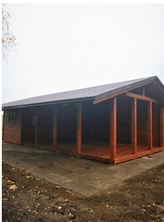
Naujai statoma pavėsinė
